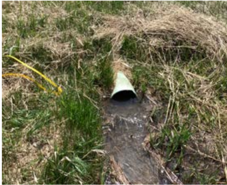
Diversion 9 - Diversion outlet, 10" pipe.
